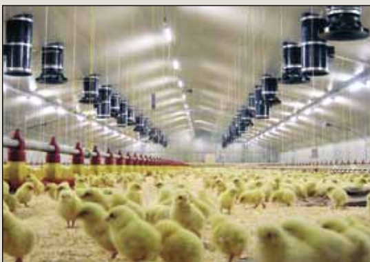
En test af ventilationssystemet Corona fra DACS A/S i fjerkræproduktionen Binadan viste en reduktion på 45-50 procent på varmekonsumet i forhold til det konkurrerende firmas system.
