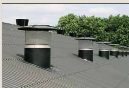
FAU 710 udsugere er modulopbygget og kan tilpasses enhver bygningstype.
